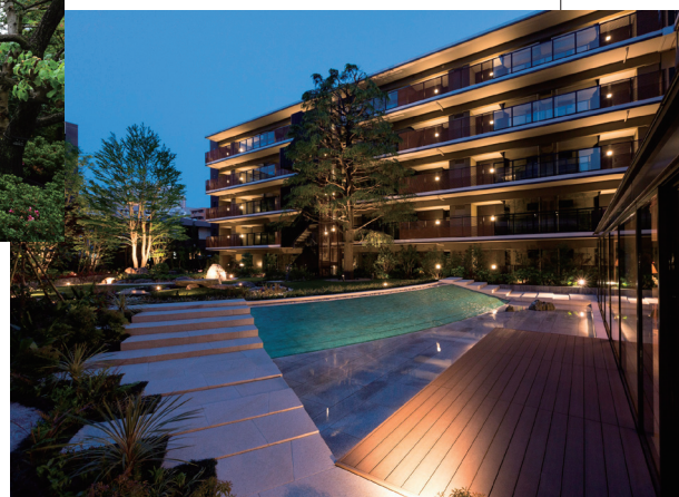
6500㎡の敷地を開発。中庭から見た美しい夜景
