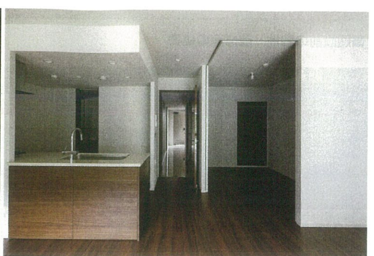
同左。右はフレックストア（可動間仕切り）。床は二重床の上オレフィンシートフローリング。天井高は2,400mm。
