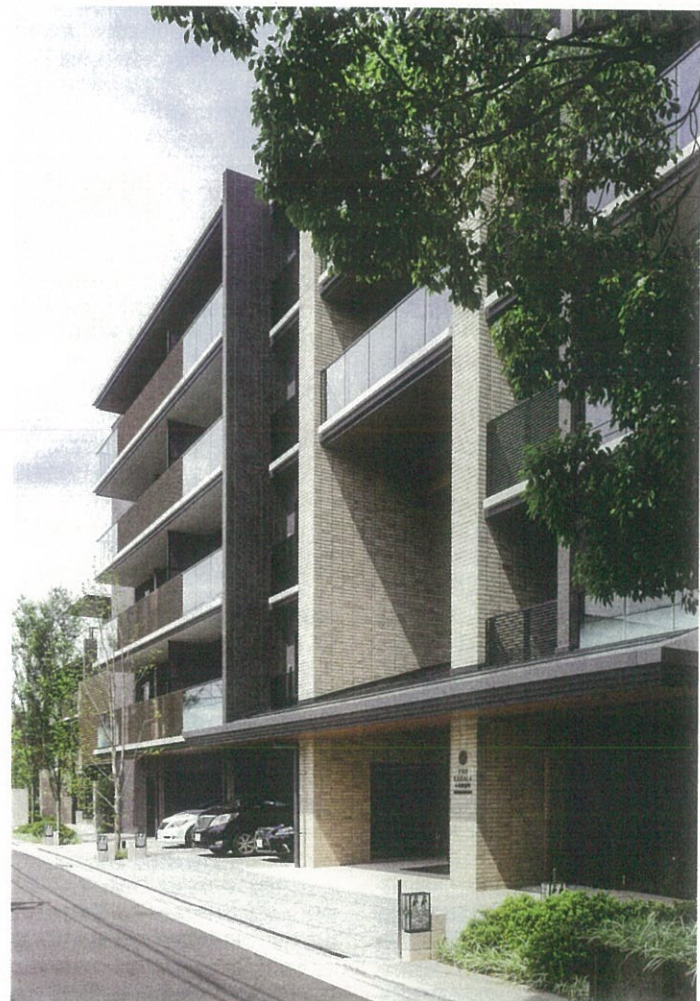
西側道路より賃貸棟エントランスを見る。外装は、旧母屋の黒漆喰の壁のイメージを踏襲したヨコシジ面いぶし風施釉タイルと職人の手の跡の残る柘榴質タイル「クレイマイスター」。
