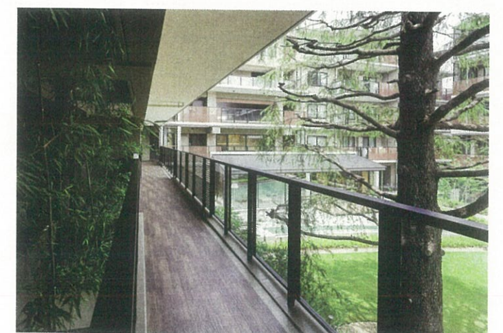
賃貸棟共用廊下。左は吹き抜けになっている。手摺をガラス張りすることで、中庭との連続性を出している。床は木目調外部用塩ビシート。天井高は2,600mm。
